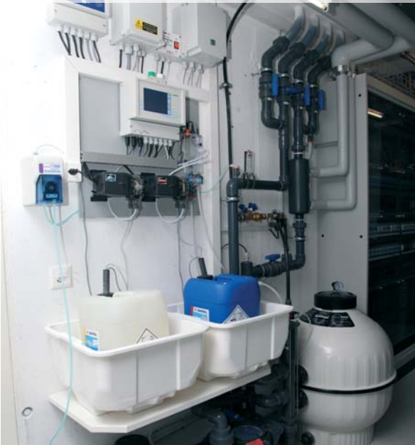
HINTER DEN KULISSEN Hier ist auch der Technikraum strukturiert. Eine ausgefeilte Wassertechnik sorgt für desinfiziertes Badewasser.
