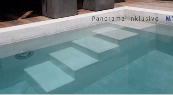
GEPRÄGT Die Einbauteile wurden an das charakteristische Schalungsmuster des Betonpools angepasst. Massiv: die Treppe.
